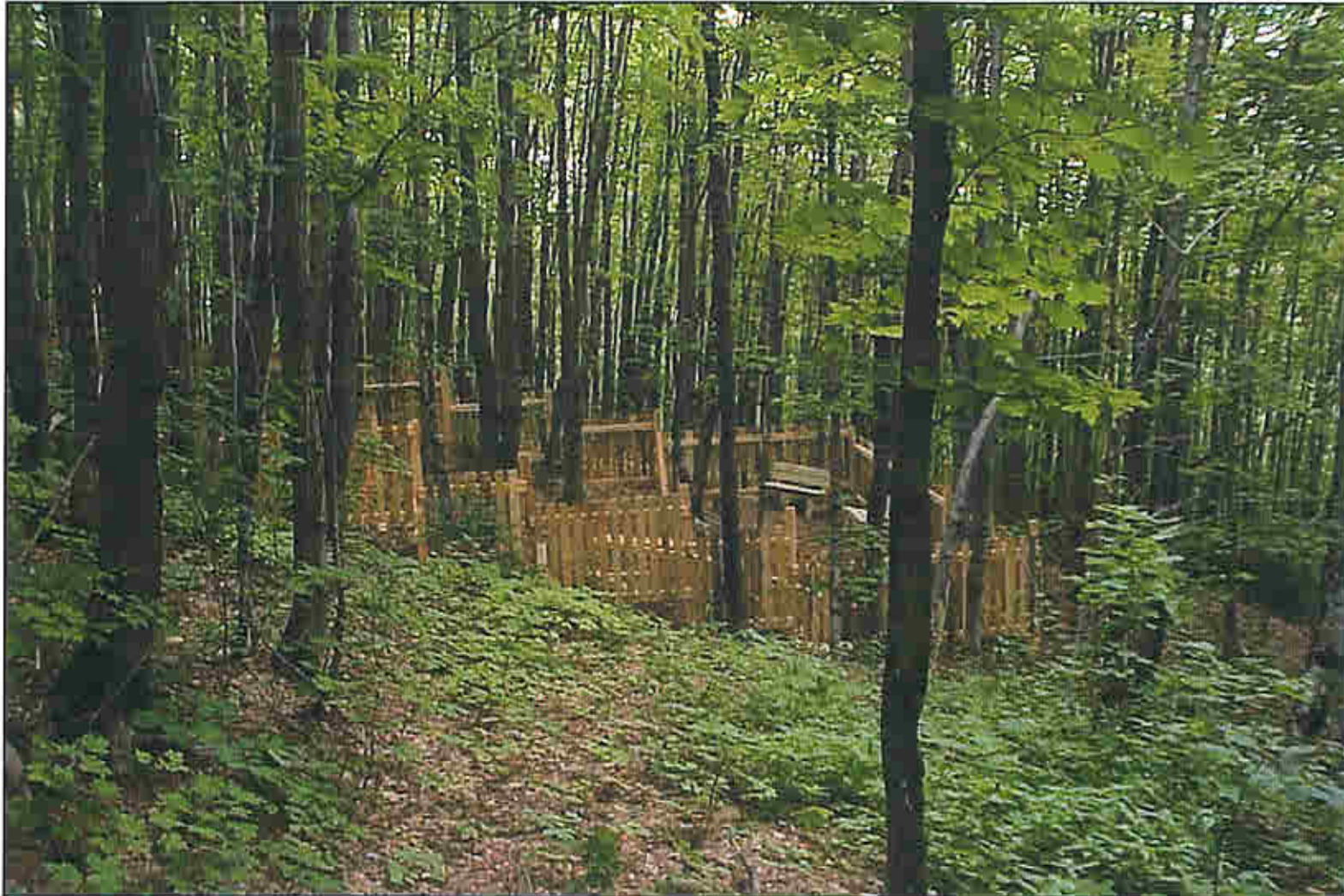
Construction des clôtures de délimitation des sites
