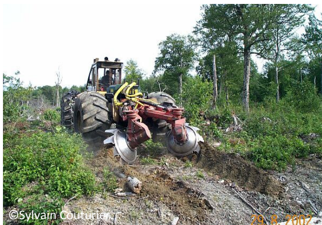
Photo 2. Préparation de terrain mécanisée
