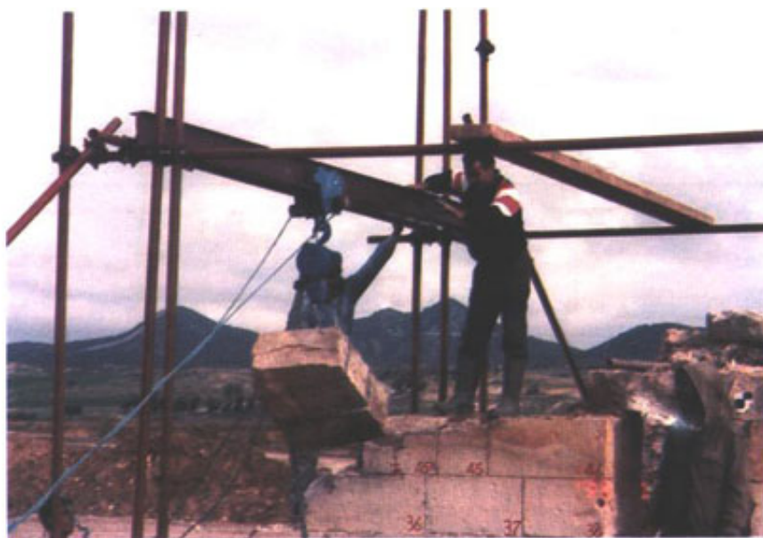
Photo 1 : Opération de démontage du temple de Oued R'mel après la numérotation systématique des différentes pièces suite à l'utilisation de la technique de la Photogrammétrie.
